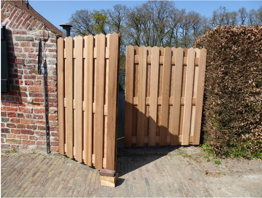
In april werden de, in eigen beheer gemaakte, deuren naar het terras achter het schathuis geplaatst
